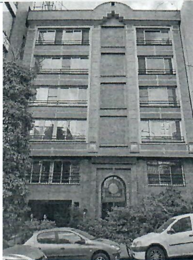
نمای شمالی ساختمان
